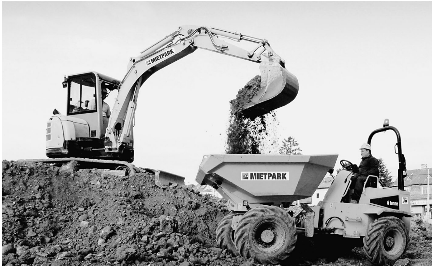
Minibagger und Dumper von HKL unterstützen bei Supermarkt-Neubau in Wien.
