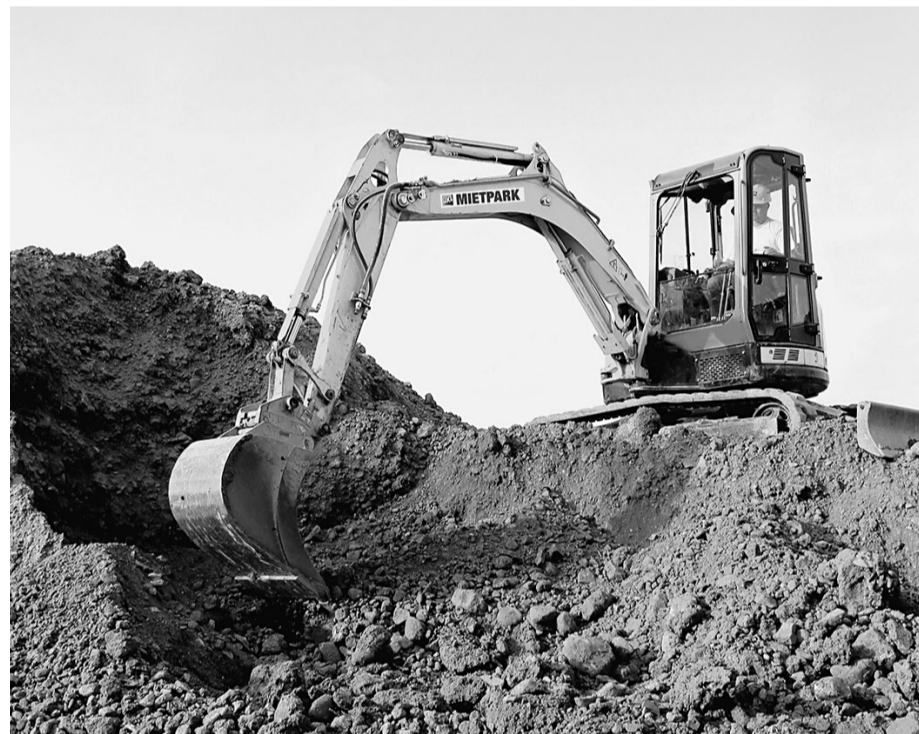
Starker Helfer: Ein Minibagger aus dem HKL Mietpark übernimmt Erdbewegungsarbeiten in der Speisinger StraÙe in Wien.
