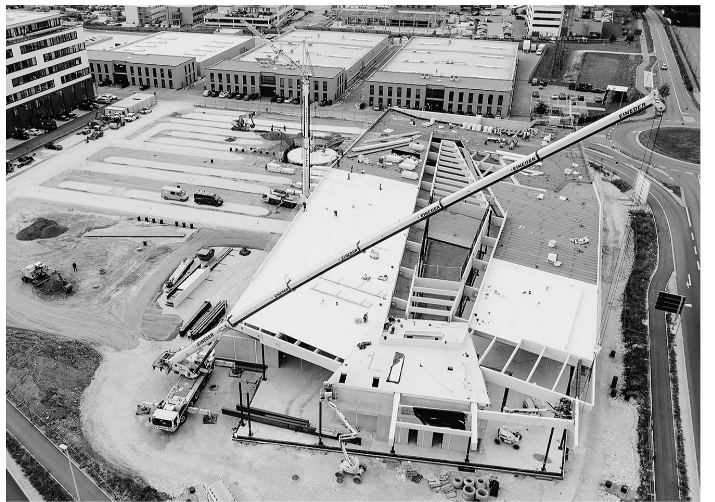
Das Unternehmen hatte sich zum Einheben der Dachelemente für den Explorer 5800 Kran entschieden.
