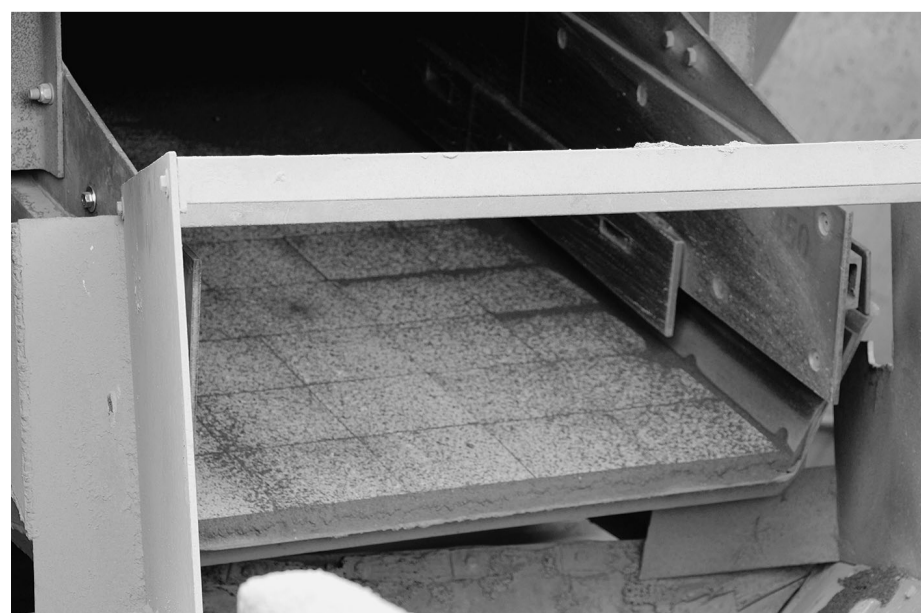
Im Aufprallbereich des Brechgutes wurden RWEV PU Kacheln in zwei unterschiedlichen Formaten 250 x 300 und 200 x 200 mm verbaut. FOTO: RWEV
